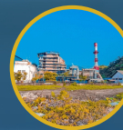
Observasi PLTU Tidore & Pengambilan Data Operasional
